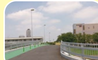
新志茂橋の耐震化
