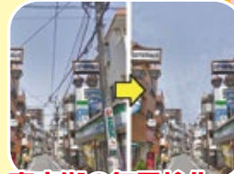
商店街の無電柱化
